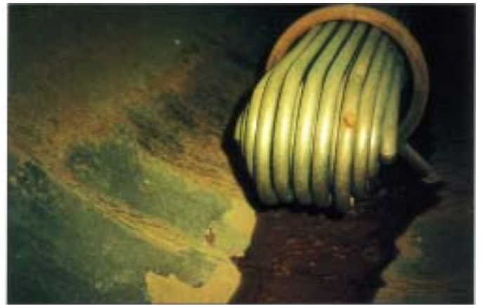
Nach 2 Monaten Spülung mit Hochdruckreiniger
