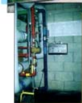
Installation des D-CALC P-52 auf der Kaltwasserzufuhr und des D-CALC Plus auf dem Warmwasser- rücklauf.
