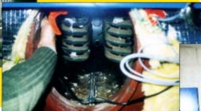
Öffnen des Warmwasser- boilers nach ca. 5 Monaten.
